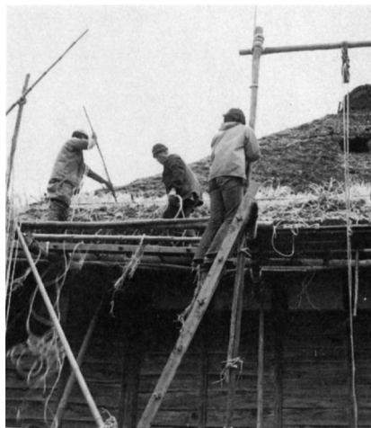
第16図 ハリをさす、屋根裏でハリにカラゲナワを通す 織茂富雄家 (南山田・昭和51年)
