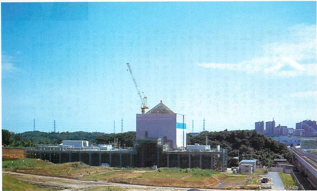
センター北駅からみた建設工事中の横浜歴史博物館 (仮称) (平成5年8月撮影)
