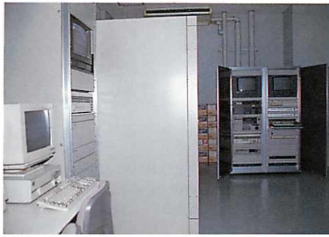
情報機器室の内部
