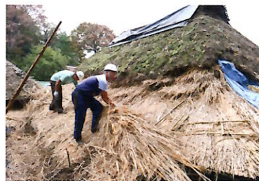
平成30年の茅葺屋根葺き替え作業の様子
