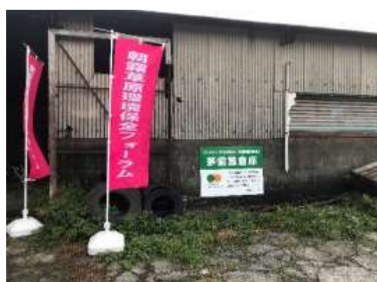
茅倉庫外観と助成銘板
