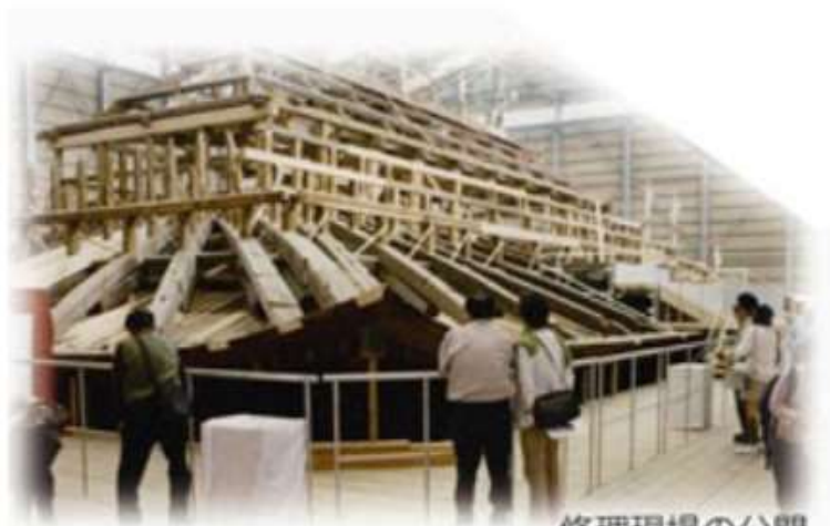
修理現場の公開
