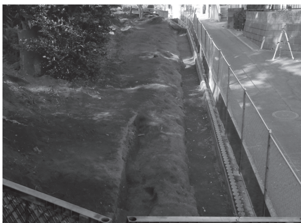
6. 調査区南側部完掘全景（南から）
