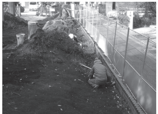
11. 作業風景(南から)
