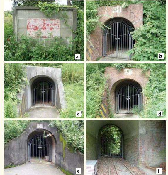
「工室」と呼ばれる火薬類を製造する建物や火薬庫の周囲は土塁で囲われ、b~fはその土塁の出入り口となるトンネル部分。トンネル内にも退避場となる空間がある。保存された8本のトンネルのうち、7本がレンガ造、1本がコンクリート造。トンネルの坑門には工室での製造工程を示す記号がある。
