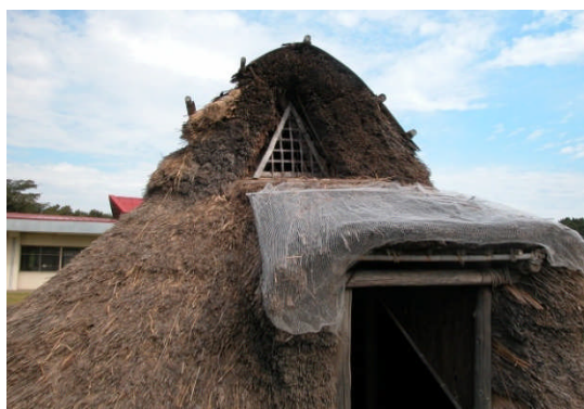
弥生時代復元住居修繕の様子
