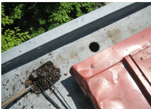
事務棟屋根清掃の様子
