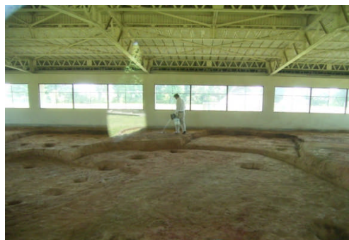
露出展示遺構保全作業の様子
