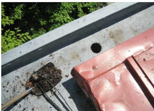
事務棟屋根清掃の様子
