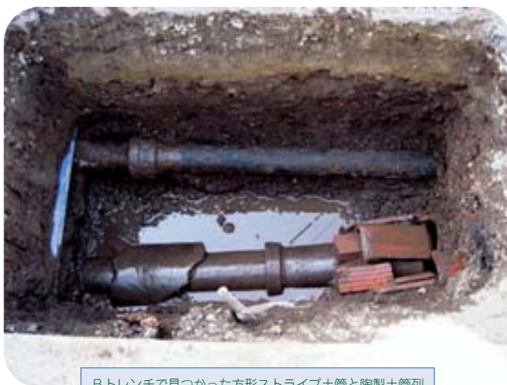
Bトレンチで見つかった方形ストライプ土管と陶製土管列
