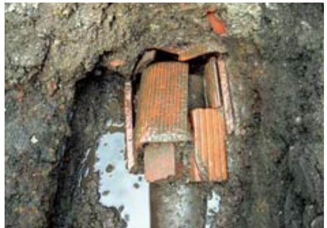
Bトレンチの方形土管と陶製土管の接続部
